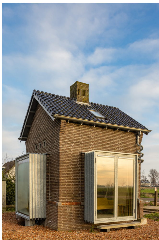
Gammel transformerstation omdannet til "vandrehytte" for vandrerne, Lautenbag Architectuur © Bas Gijssels
